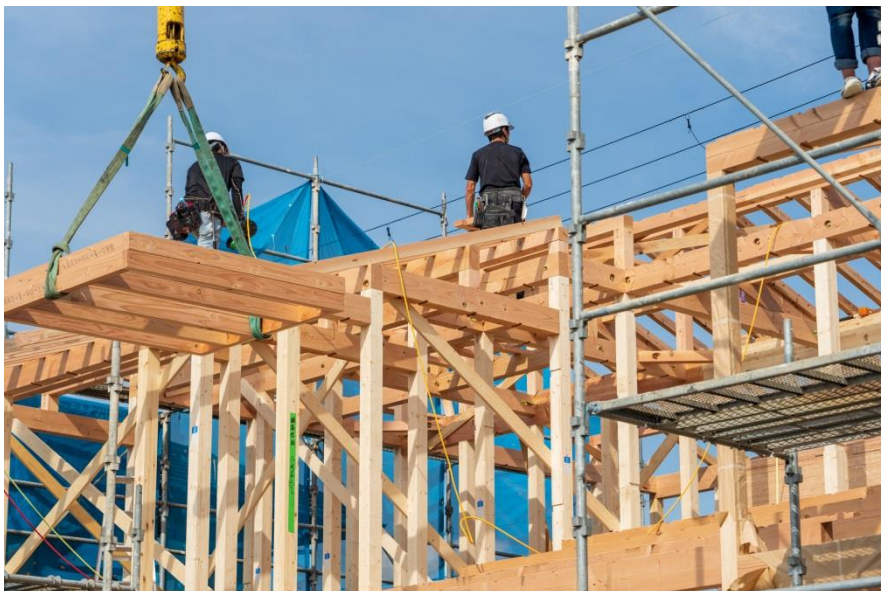
住宅建設の現場でも登録建築大工技能者のスキルとリーダーシップは重要視されています
